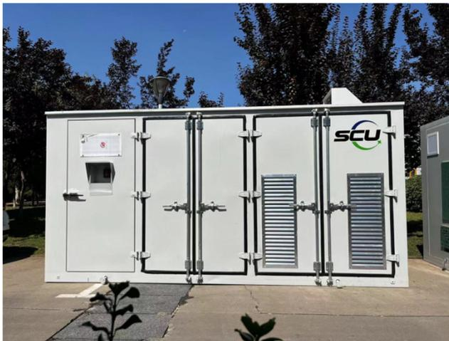
Abb.: Beispielprodukt Batteriespeicher [LadeEngel]
