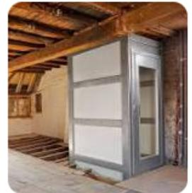
Bei dem Einbau eines außenliegenden Aufzugs entsteht auf jeden Fall eine erhebliche Kältebrücke, einmal durch die Montageanbindung, dann aber auch jedes Mal, wenn sich die Türen oben bzw. unten öffnen.
