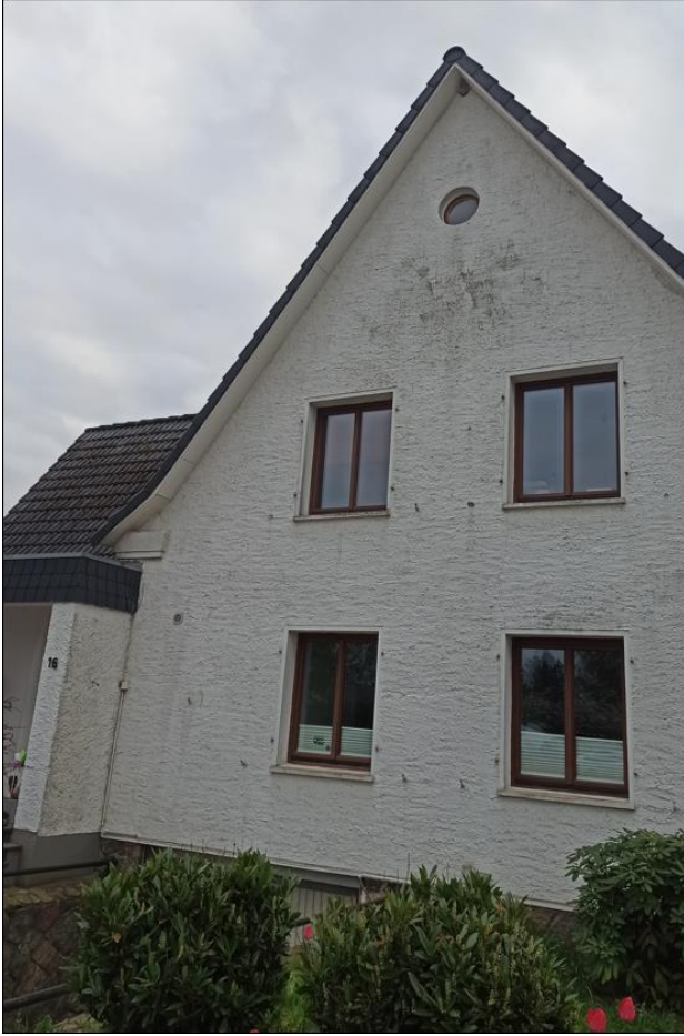
Gebäude im östlichen Baufenster an der Theodor-Körner-Straße.
