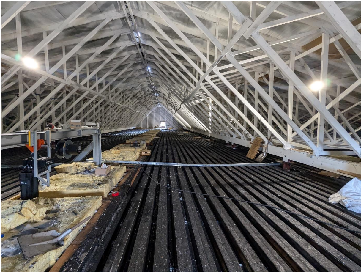
Abbildung: Zwischenstand Abbruch altes Flachdach
