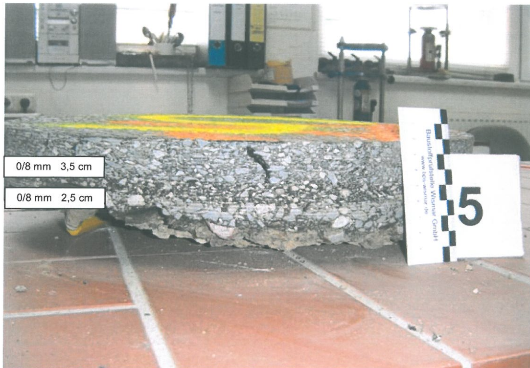
Bild 9: Bohrkern 5 Entnahmestelle: Nüssauer Weg km 0+935
