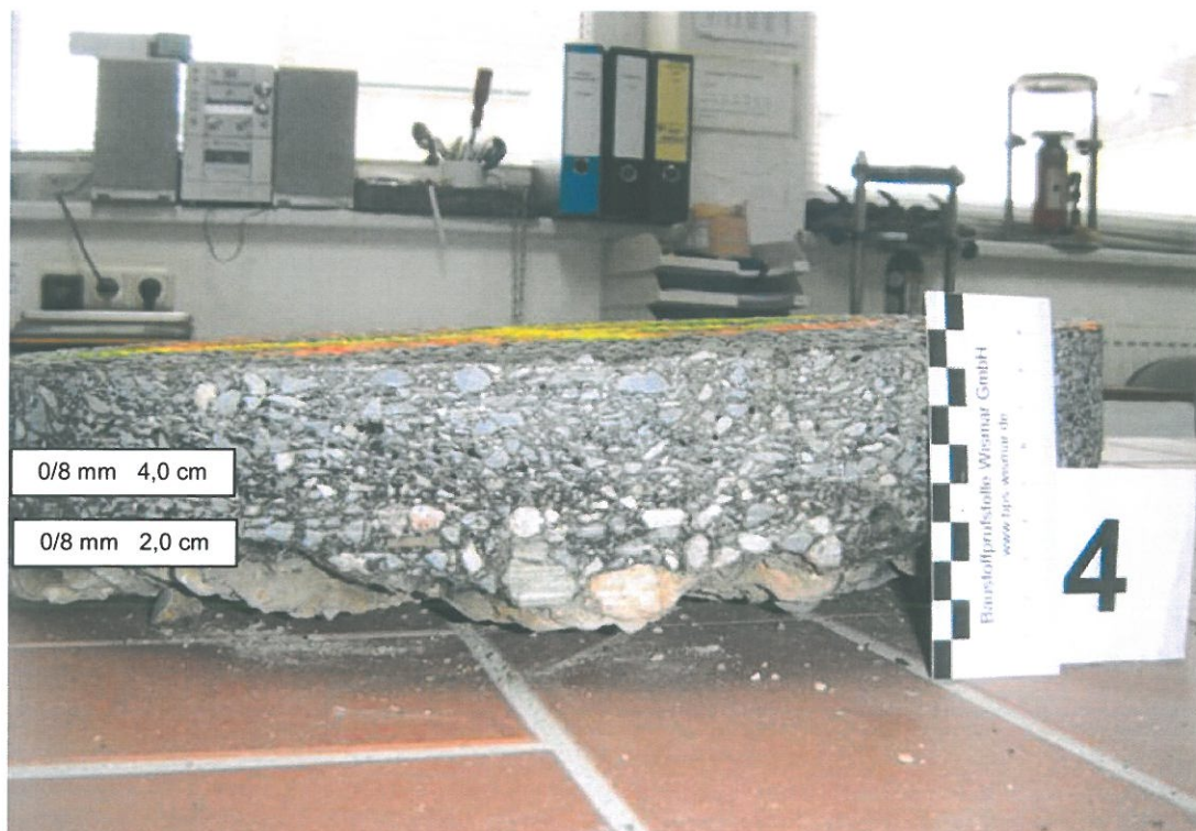
Bild 8: Bohrkern 4 Entnahmestelle: Nüssauer Weg km 0+669
