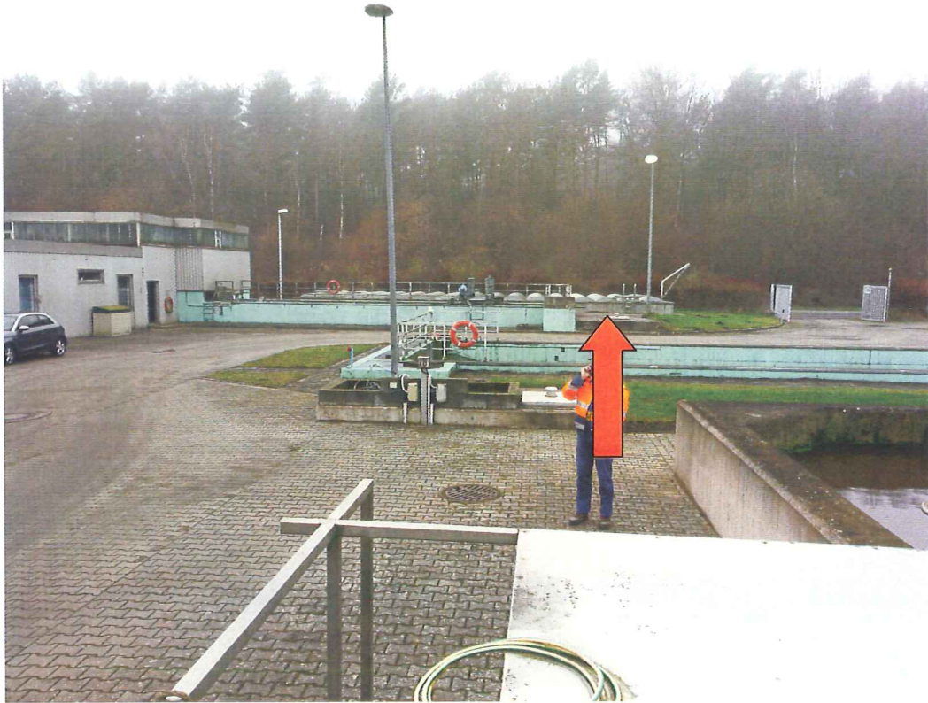
Abbildung 3.2: KA Büchen Rechen und Sandfang, Ausgleichsbecken (Pfeil)
