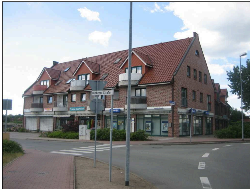
Abbildung 3: Vorhandenes Wohn- und Geschäftshaus am Kreisverkehr
