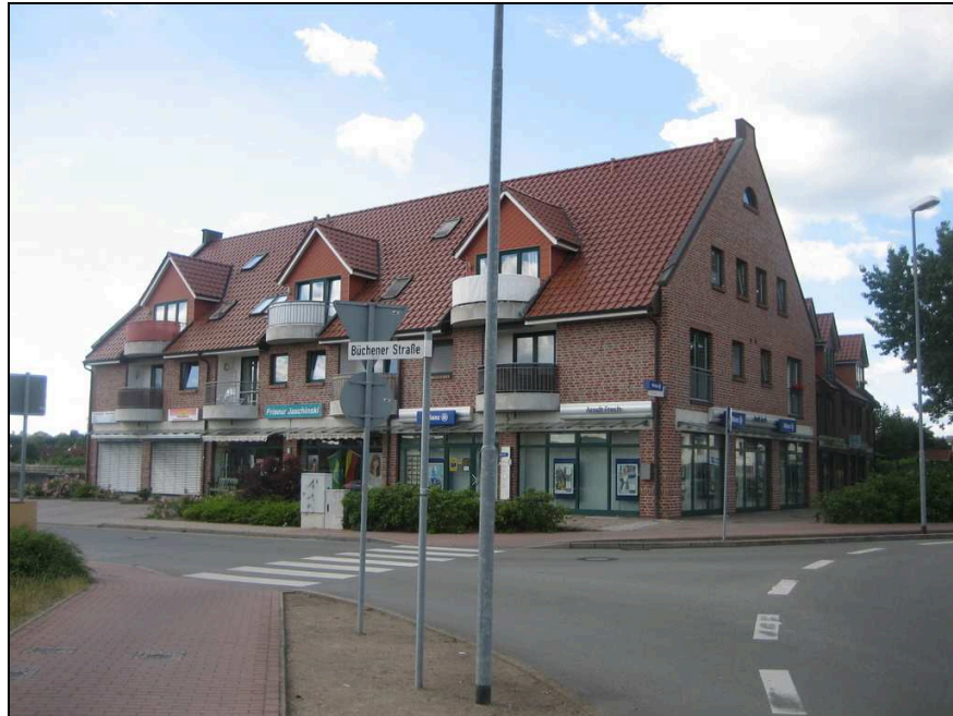
Abbildung 3: Vorhandenes Wohn- und Geschäftshaus am Kreisverkehr
