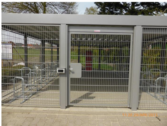
Abb. 12: Beispiel einer Sammelschließanlage mit RFID-Zugangskontrolle am Bahnhof Ritterhude
