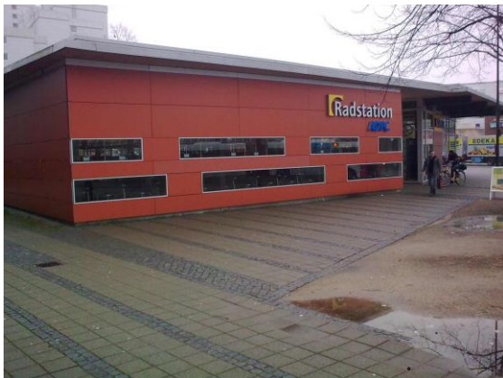
Abb. 1: Radstation am Bahnhof Bremen-Vegesack
