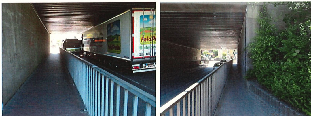
Abbildung 7: Gehwegbreiten - Hamburger Eisenbahnbrücke (links Süd- und rechts Nordseite)
