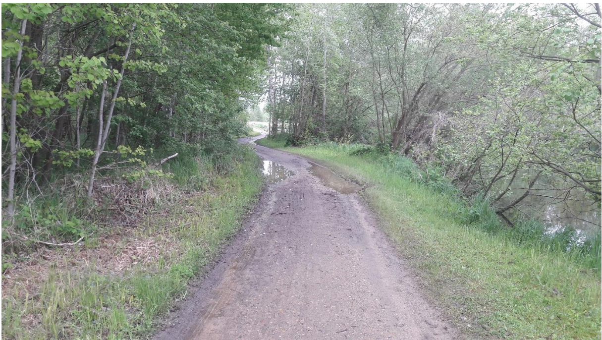
Fotos 5 und 6 Verlauf des nördlichen Weges mit Matsch und Pfützen durch KFZ-Verkehr
